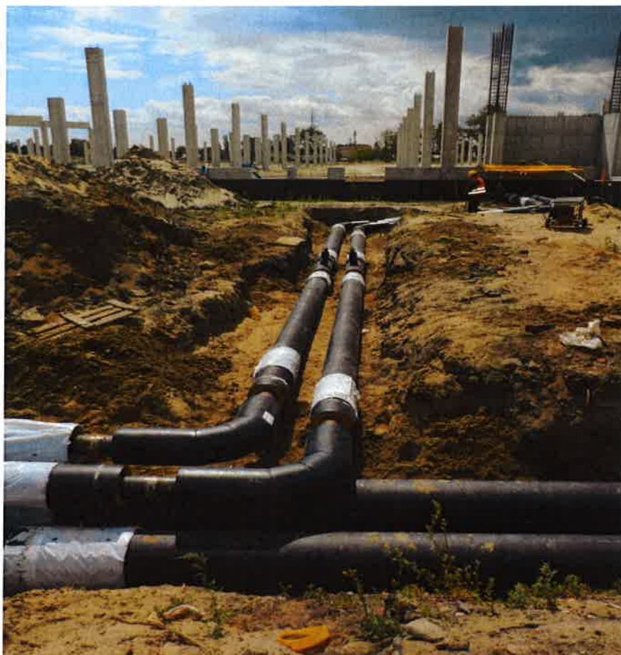
Zdj. 3 Budowa sieci ciepłowniczej na terenie Galerii Handlowej.
