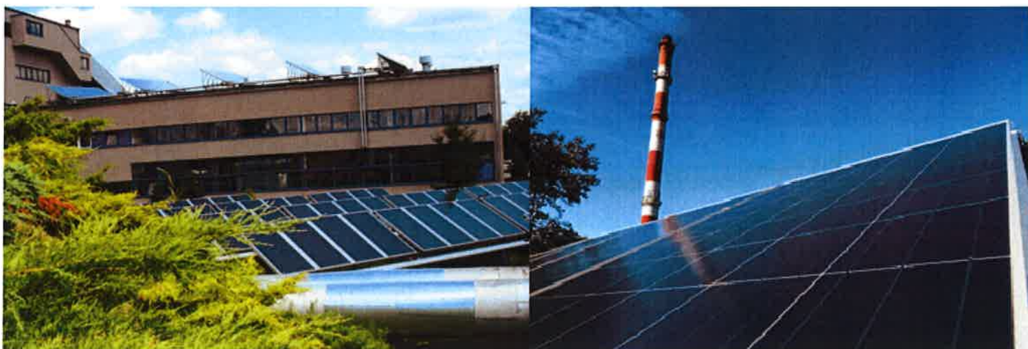
Zdj. 4 Kolektory słoneczne oraz panele fotowoltaiczne w Zakładzie Energetyki Ciepłej w Wołominie.
