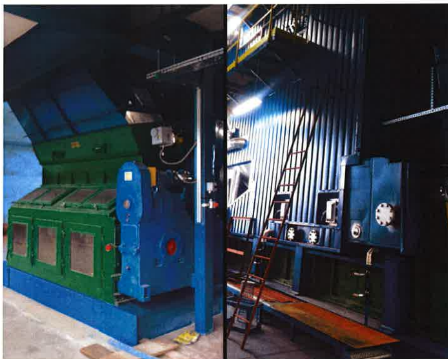
Zdj. 1 Kocioł WR-10 w trakcie budowy.
